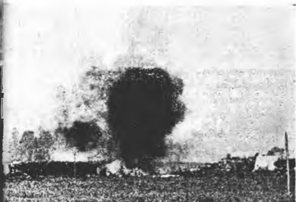
5. zīm. Spridzināšana ar pikrīnskābi. Raksturīgi melnie pikrīnskābes dūmi.
