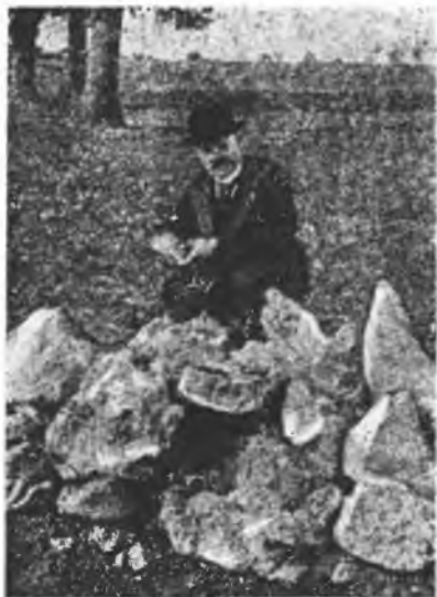
53. zīm. Bez iekalšanas no virsas saspridzināts akmens.
