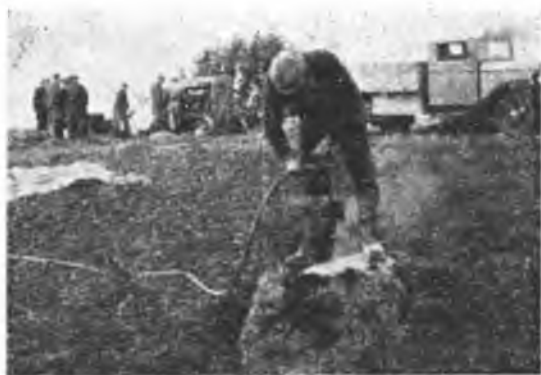
50. zīm. Caurumu kaļšana akmenī ar kompresora iekārtu.
